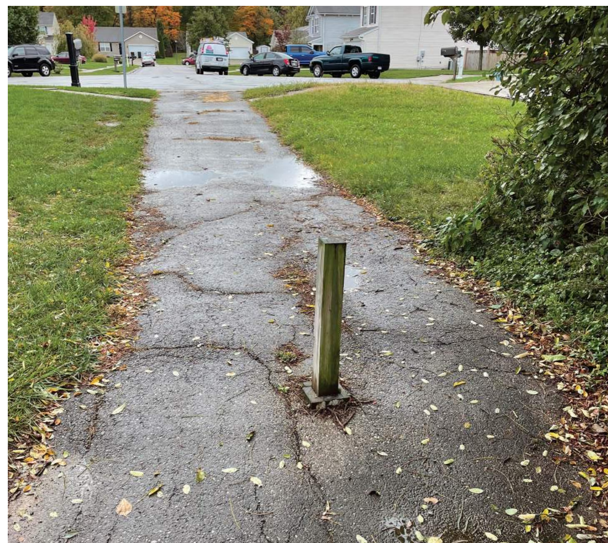
G. EXISTING WOODEN BOLLARD
